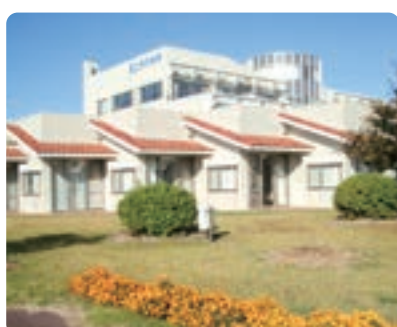
緩和ケア病棟外観
