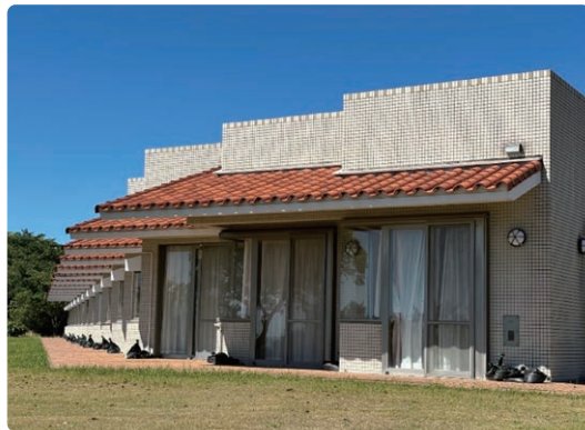
緩和ケア病棟外観
